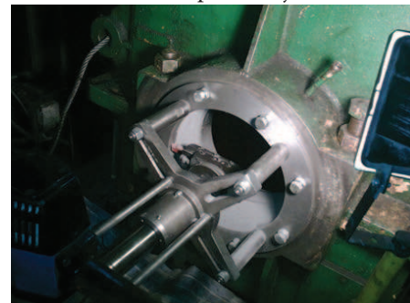
obr. č. 3 Oprava uloženia prevodovky nanesením plastického kovu a obrobením na mieste
