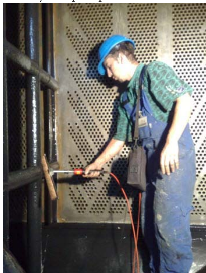
Obr. Meranie neporušenosti náteru
