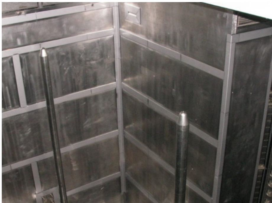
Obr. 12 Dutina reaktora preventívna oprava, materiál manuálne aplikovaný za suchých podmienok
