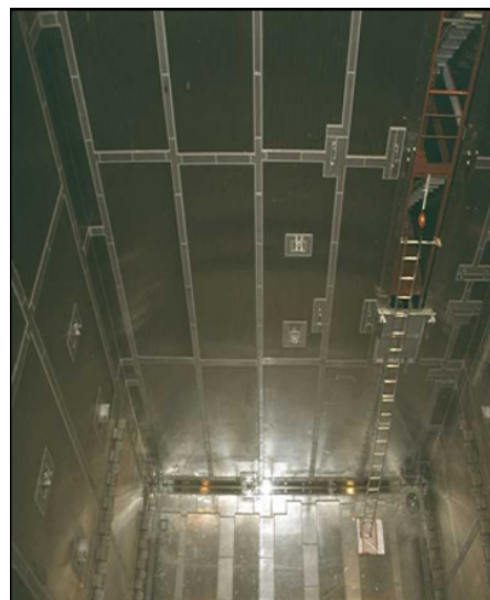
Obr. 11 SFP preventívna oprava, materiál manuálne aplikovaný za suchých podmienok
