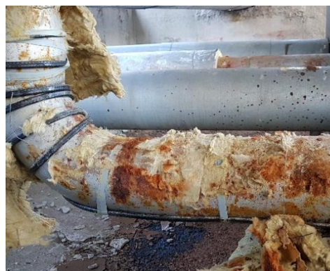
Obr. 1 Typické príklady korózie pod izoláciou
