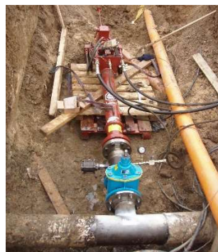
Obr. 4 Napojenie nového potrubia za prevádzky
