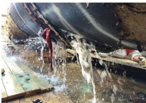
Obr. 1 Oprava potrubia za prevádzky
