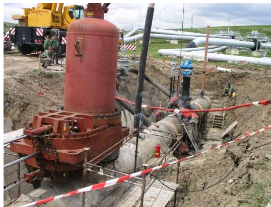
Obr. 3 Prekládka trasy potrubia za prevádzky
