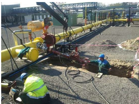
Obr. 4 Napojenie nového potrubia za prevádzky
