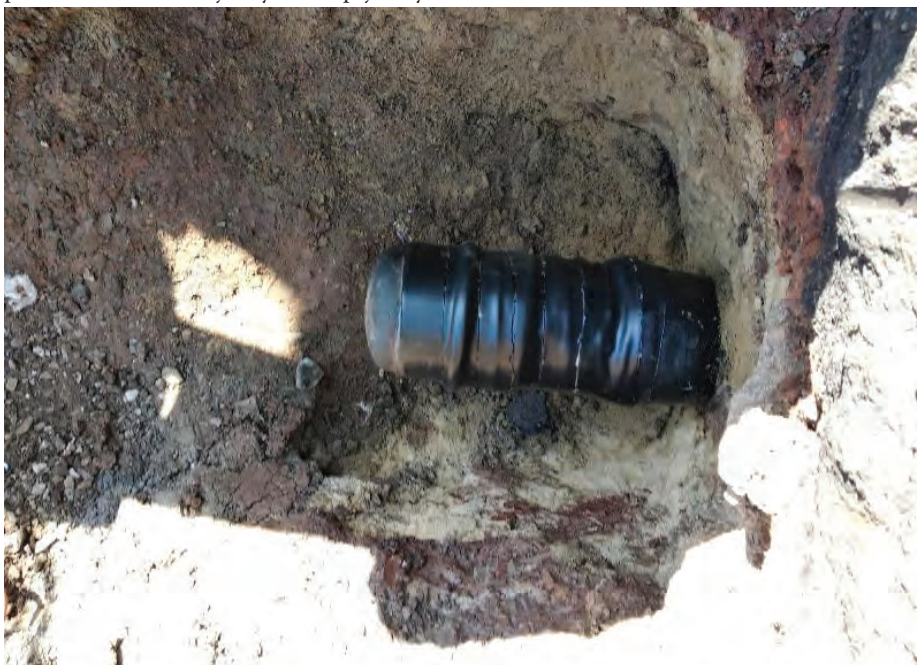
Obr. 9 Utesnenie (oprava) potrubia s priamym únikom
