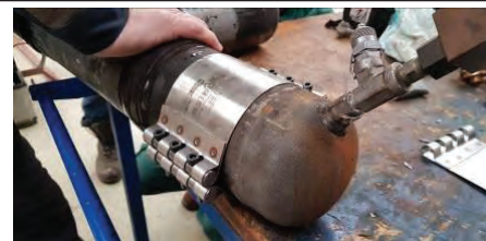
Obr. 10 Tlaková a tesnostná skúška ocelovej objímky
