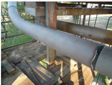
Obr. 1 Opreté potrubie o nosník
