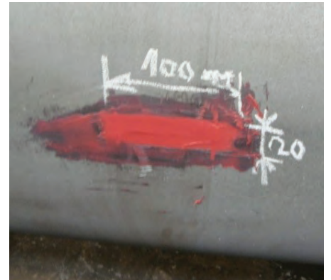
Obr. 3 Vyplnenie chyby výplňovým tmelom
