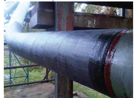
Obr. 5 Aplikácia uhlíkovej bandáže
