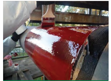
Obr. 4 Aplikácia epoxidového základného náteru
