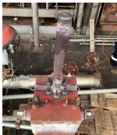
Obr.17 Odrezané jestvujúce potrubie a navarené klenuté dienko
