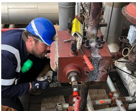
Obr.16 Demontáž zariadenia, na potrubí zostáva uzatvárací blok
