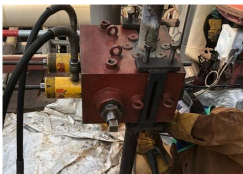
Obr.12 Navarenie uzatváracieho bloku
