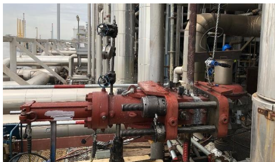
Obr.14 Uzatvorenie potrubia za prevádzky
