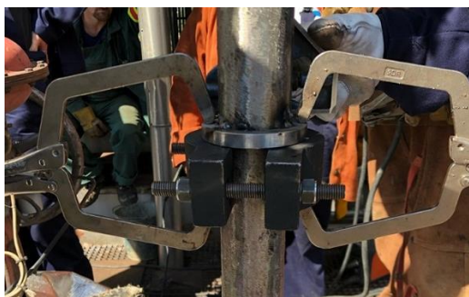
Obr.10 Navarenie výstužných prstencov
