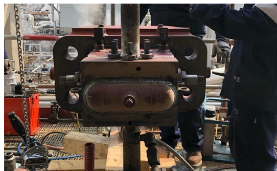
Obr.15 Navarenie privarovacieho dna
